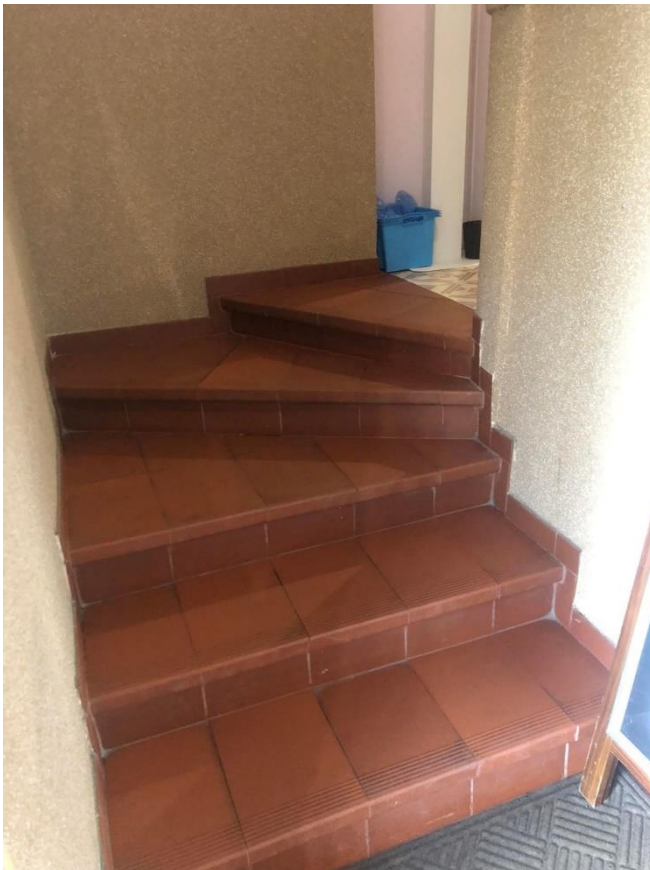
Zdjęcie schodów prowadzących na półpoziom
